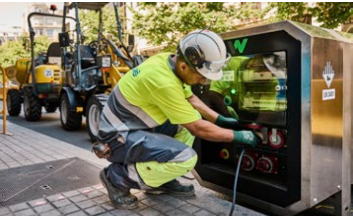
Versorgt die ganze Baustelle mit Power, autark oder im Netzbetrieb.
